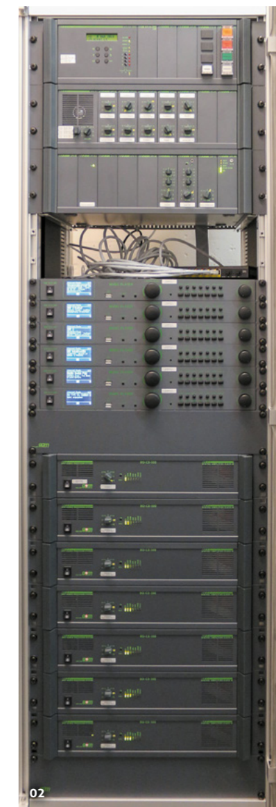
02 Herzstück Die Komponenten der Musik- und Gonganlage eingebaut in einem 19 Zoll Rack.
