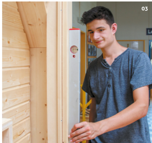
03 Präzisions- arbeit Die Wasser- waage zeigt Sergio ob alles im Lot ist.
